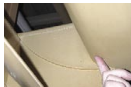
De nya luftintagen har begåvats med en klack i gavlarna, som spjället löper mot, för bättre tätning.
