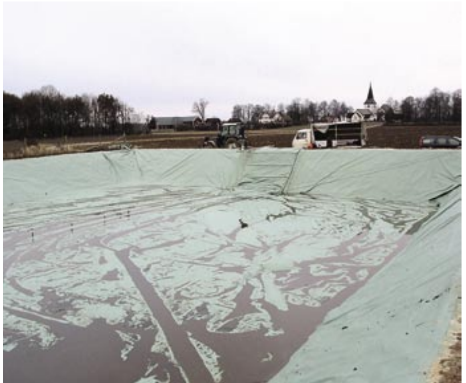
Granne med kyrkan blir den här jorrdammen för gödsel. Det ställer extra krav på tät bassäng, som inte släpper ut lukter.
