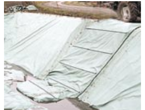
Granne med kyrkan blir den här jorrdammen för gödsel. Det ställer extra krav på tät bassäng, som inte släpper ut lukter.
