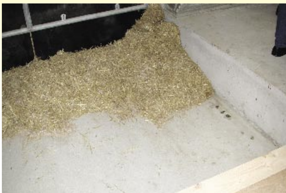
Ovan: Fördjupningen i golvet för halmbäddarna i djupströboxarna.
