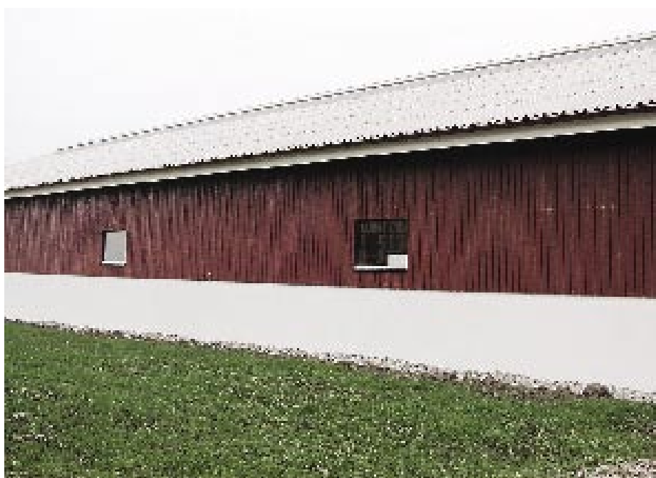
Nedan: Ekostallet med ljusgenomsläpplig taknock och med glespanel.
