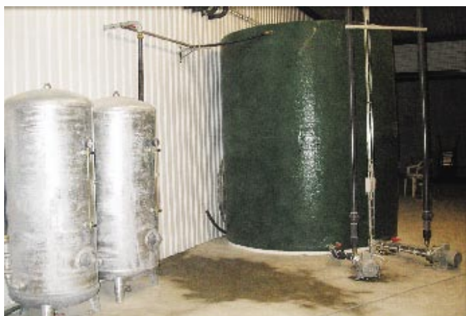
Tanken för enbart vatten till blandartankarna. Möjlighet finns för tillsättning av syra.
