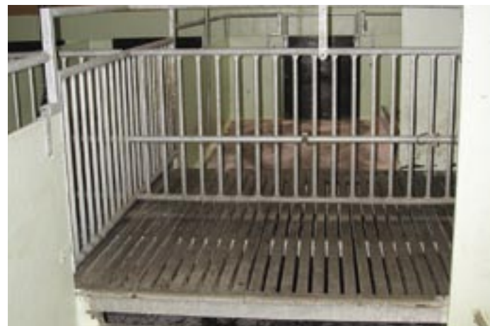
Spaltgolvet över gödselrännan i tillväxtstallet är upphöjt. I mitten finns vattennippeln på vattenröret. Det röda på golvet är hygienmedlet Staldren.
