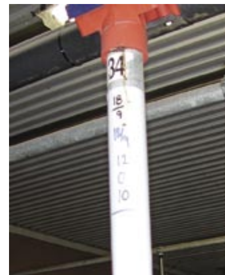
En plastremsa på foderrören för notering av händelser som vidtas.
