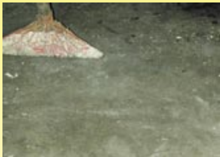
Golvytan i en behandlad grisningsbox. Ytan är tät och slät. Golvytan kan även göras något "ruggad".
