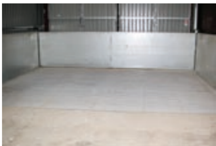
Intagsgropen mäter ca 5 x 4 meter. Rymden är 28 kubikmeter. Undertill finns ett transportband med en kapacitet på 80 ton per timme.
