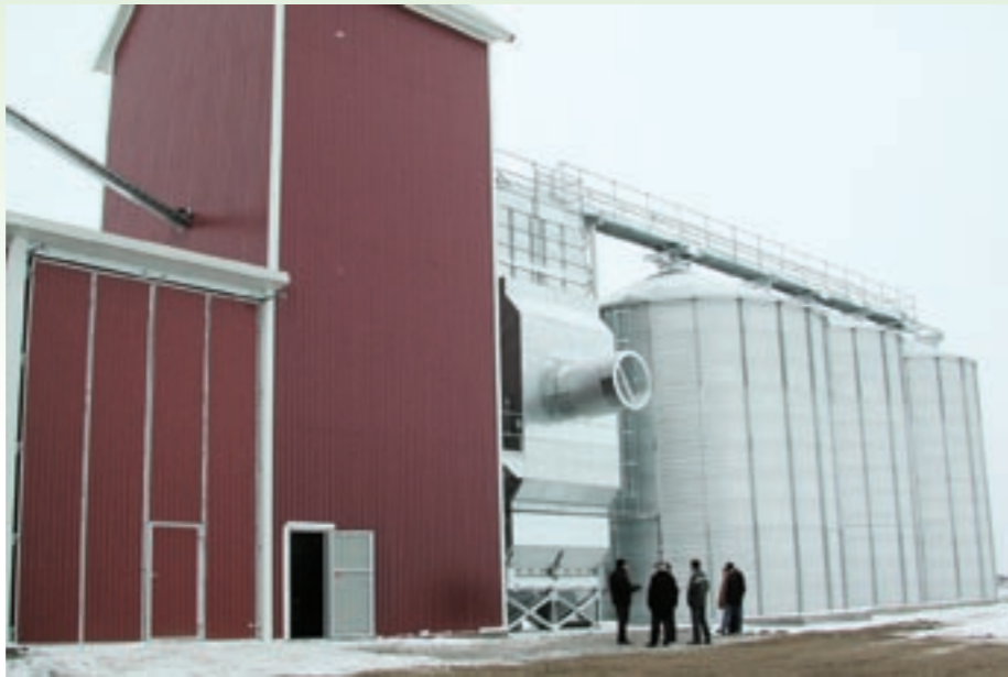
Tork- och lagringsanläggningen på Badene. T v intagsgropen med ca 6 meter hög överbyggnad där porten är lika hög. Bredvid syns huset för våtfickorna, därefter torken och lagringsfickorna. I röret ut från torken finns sugfläkt med kapacitet runt 150 000 kubikmeter luft per timme.
