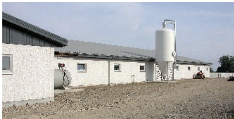
Tv entré och kontorsdel, längst bort transponderstallet och ungefär bakom oljetanken betäckningsstallet.
