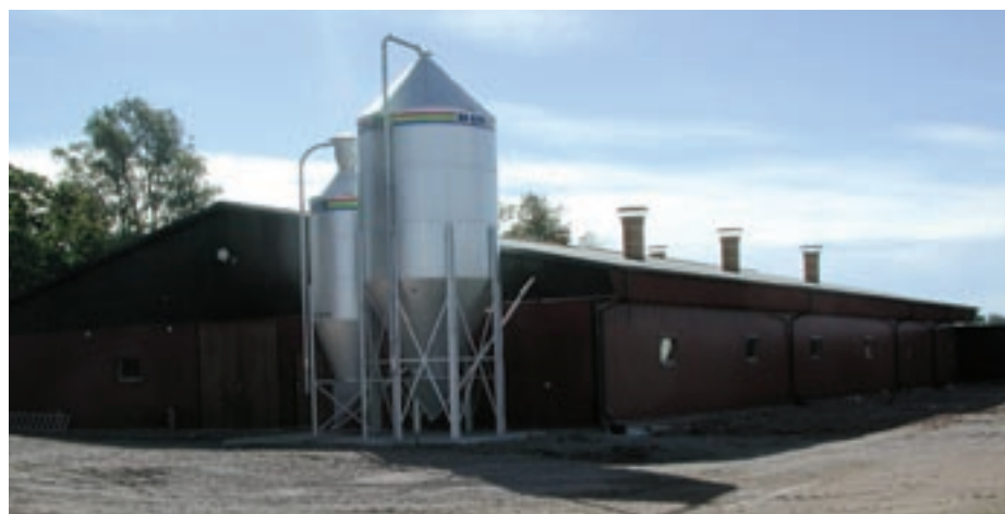
Tillväxtstallet med fodersilos utanför. Längst bak ses korridoren som har förbindelse med suggavdelningarna.
